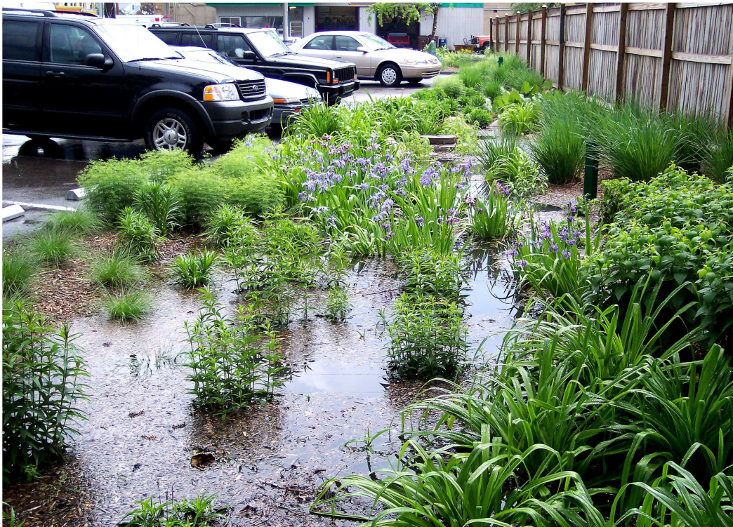
A rain garden.
